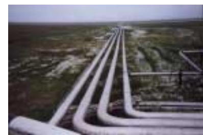
Gasleitungen im Gas-Kondensatfeld von Yamburg. Diese Pipelines transportieren Gas von den Quellen zu Raffinerien. Tazovskiy-Halbinsel, Autonome Bezirk der Jamal-Nenzen, Russische Föderation. Foto von Benjamin
