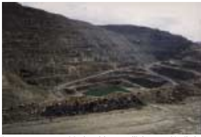
Lagerstätte von Medvezhka, südlich von Noril'sk. Ein Beispiel für eine ausgedehnte Kupfer- und Nickellagerstätte, in der ursprünglich im Tagebau abgebaut wurde, die jedoch heute fast ausschließlich unter Tage ausgebeutet wird.
