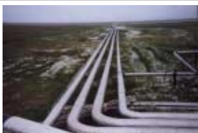
Gasledninger ved Yamburg gasfeltet. Disse rørledninger flytter gas fra kilderne til forarbejdningsanlæggene. Tazovskiy Peninsula, Yamalo-Nenetskiy AO, Russiske Føderation. Foto af Benjamin Seligman, August 1998
